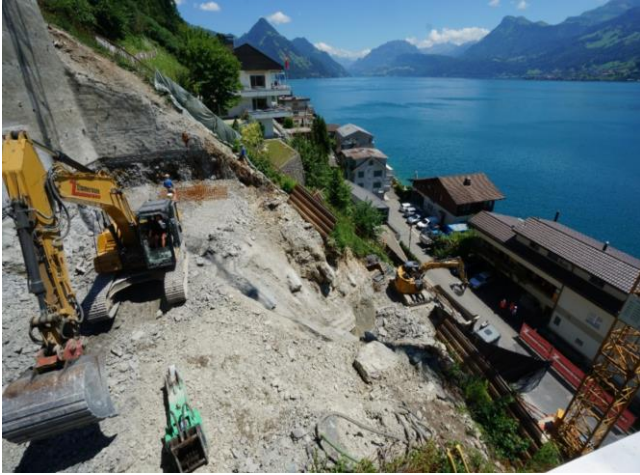
Baustart bzw. der Aushub ist erfolgt
